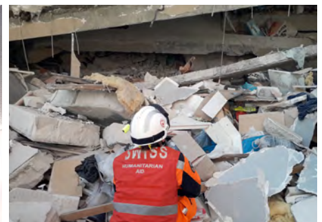
Baustatiker vor Ort
