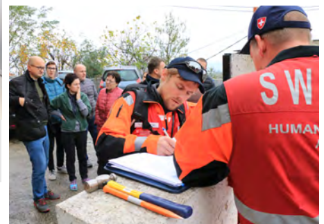
Structural Engineers und Onsite Advisors prüften zusammen mit albanischen Ingenieuren die Stabilität beschädigter Wohnhäuser
