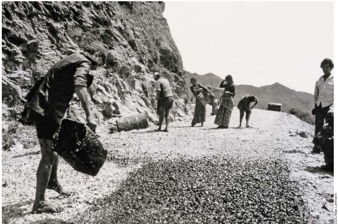
Au Népal (ci-dessus et ci-contre), la Suisse s'est beaucoup investie dans la construction de routes et de ponts
