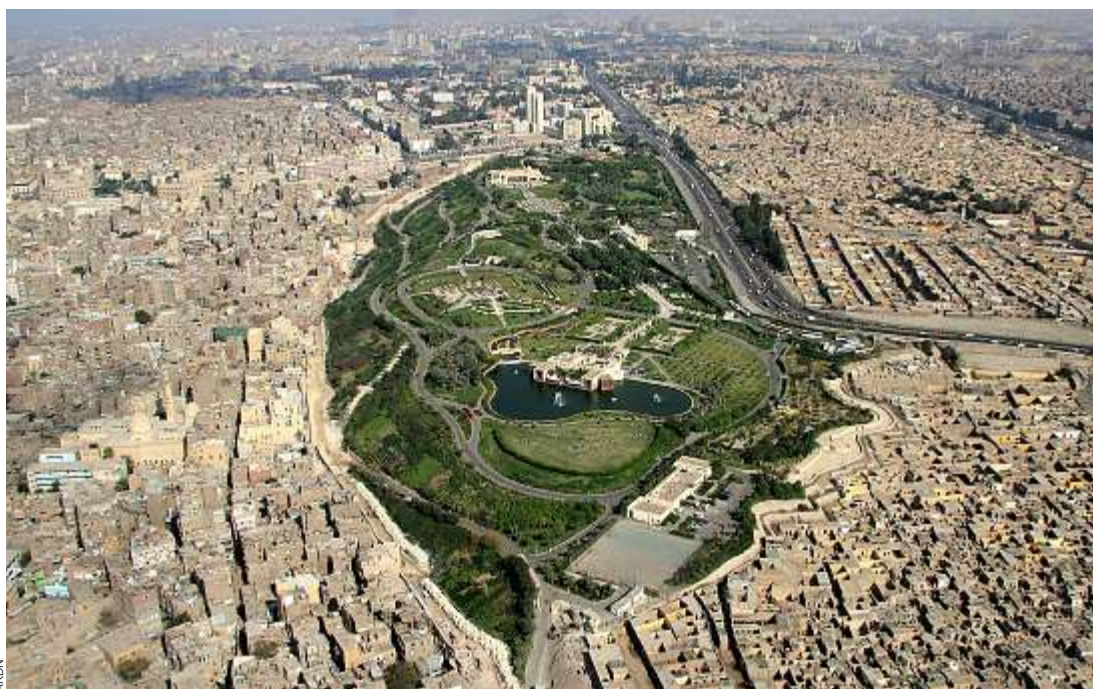
Der 2005 eingeweihte, 30 Hektaren grosse Park Al-Azhar in Kairo wurde vom privaten Genfer Aga Khan Development Network erstellt. Heute unterstützt dieses im angrenzenden Quartier Darb al-Ahmar – einem der ärmsten in Ägyptens Hauptstadt – soziale Projekte.
